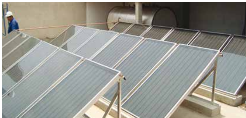
Fig. 15 Instalações de aquecedores solares sobre lajes impermeabilizadas no Brasil
