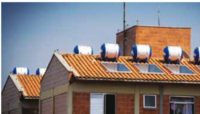
Fig. 37 SAS em HIS com reservatórios horizontais
